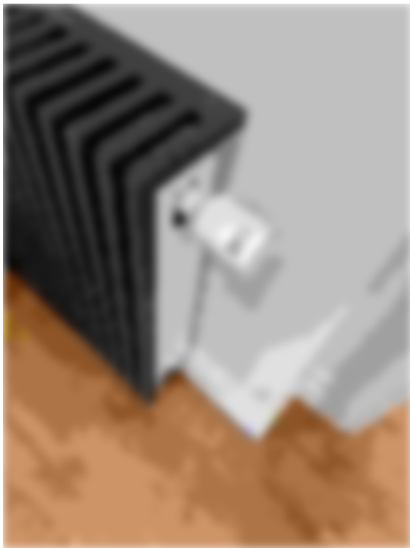
Смарт-головка на батарее
